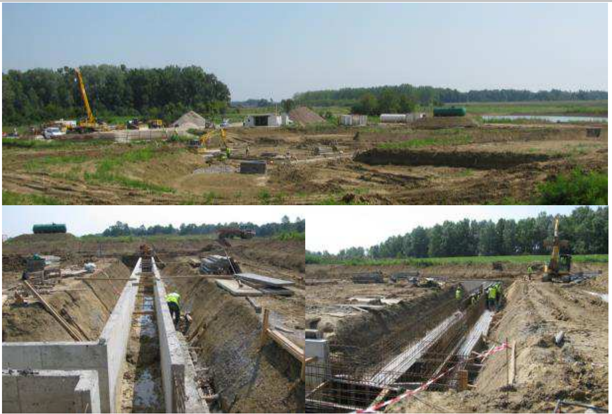
Slika 2.1-20. Izgradnja crpne stanice u sklopu izgradnje 3. dionice
