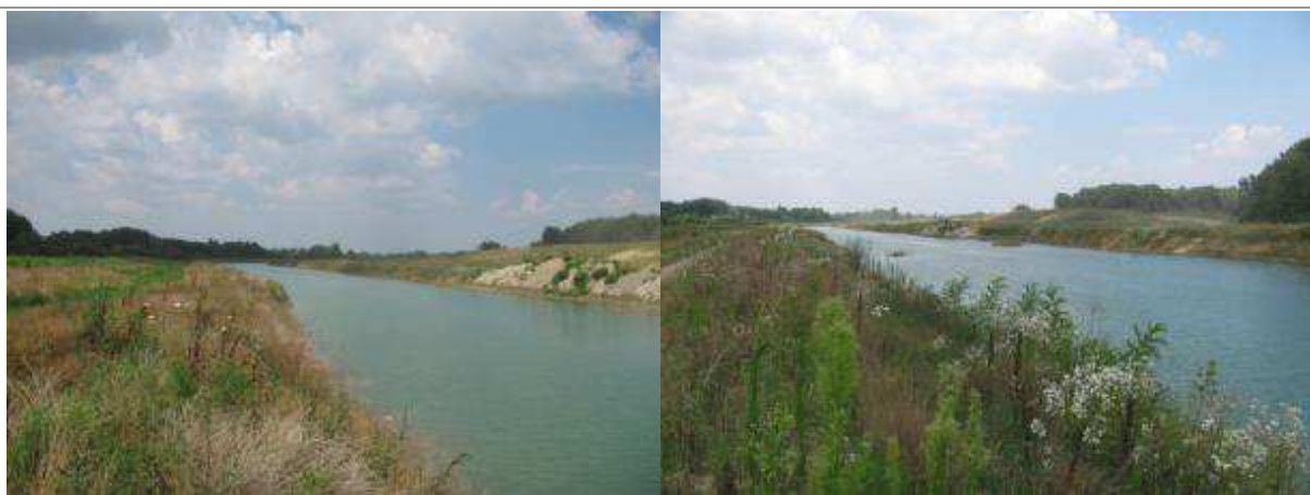
Slika 2.1-19. Početak 2. dionice (lijevo) i spoj sa 6. dionicom (desno)
