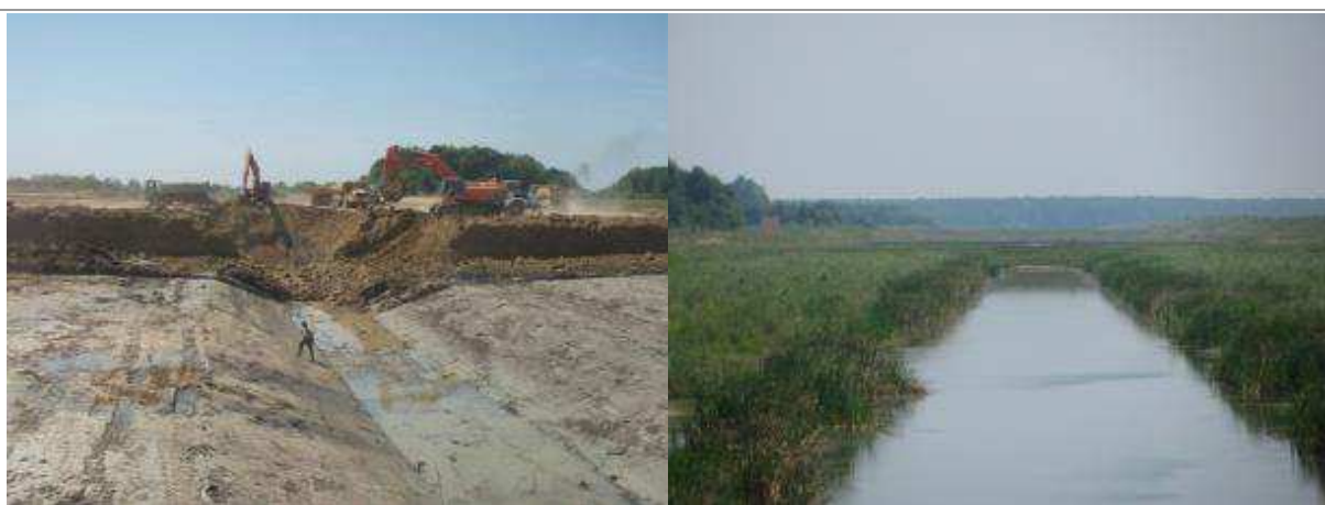
Slika 2.1-16. Kanal na 1. dionici tijekom izgradnje (lijevo) i nakon izgradnje (desno)
