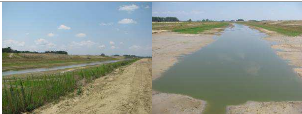
Slika 2.1-18. Melioracijski kanal s obostranim inundacijama na drugoj dionici
