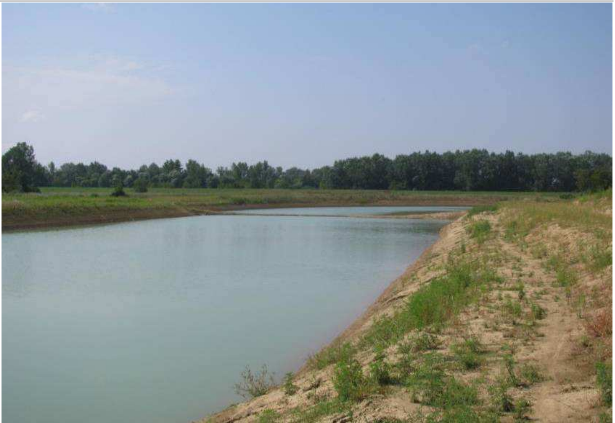
Slika 2.3-3. Pogled na novoformirani iskop kanala prema crpnoj stanici s pogledom na Savski nasip i aluvijalne šume
