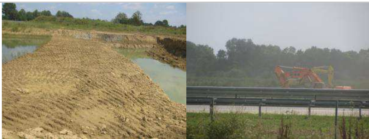
Slika 2.1-22. Početak iskopa 5 dionice u 2+538 km prema državnoj cesti D7
