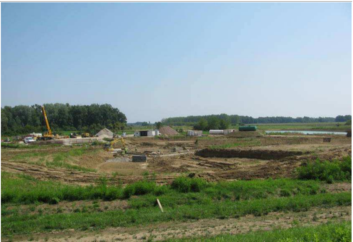
Slika 2.3-4. Pogled s nasipa na gradilište crpne stanice
